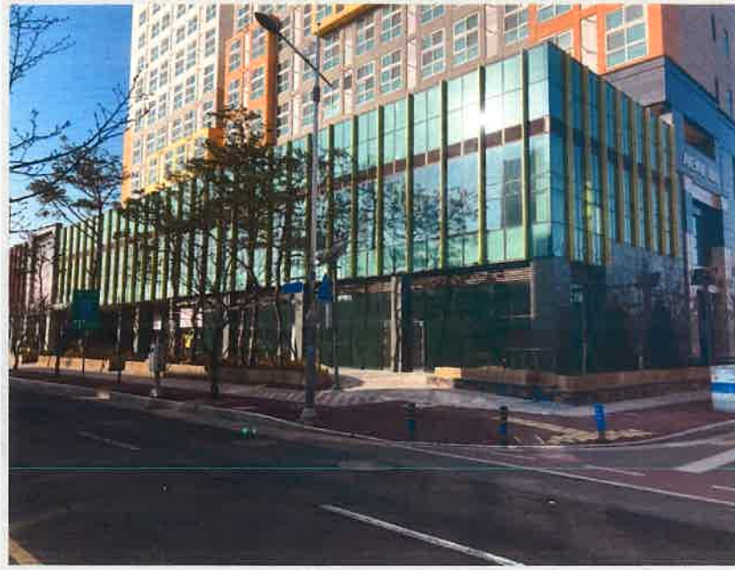
【본건 1층 전면 상가】
